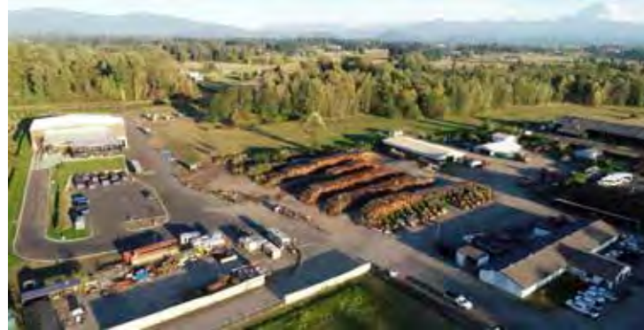
MIT Transfer Station, Firewood Pile and Public Works Bldg.
